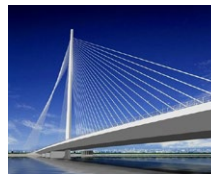
Puente Da Nang (VN)
