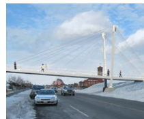
Puente Revere (EE.UU.)
