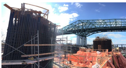
Instalación del primer sensor en las torres principales
