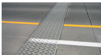
Una junta de dilatación modular con reducción de ruido "sinus plates" en la superficie
