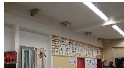
Vista interna de una habitación en donde los amortiguadores habrán de ser fijados al techo
