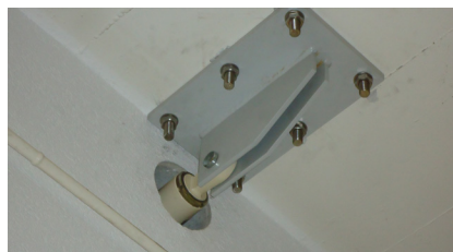
Extremo de un amortiguador RESTON®SA instalado a través de la pared
