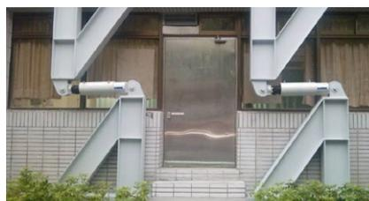
Vista cercana de un amortiguador RESTON®SA, tal como está instalado
