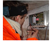
Prueba de funcionamiento
