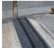
Junta dentada deslizante
