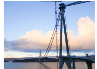
Puente Hålogaland, Noruega
