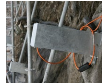
Monitoreo de bulones en taludes
