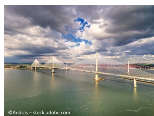
Cruce Queensferry, Reino Unido
