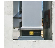
Apoyo elastomérico reforzado
