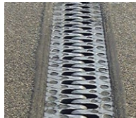
Junta dentada en voladizo
