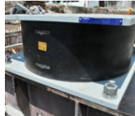
Apoyo elastomérico con núcleo de plomo
