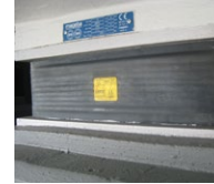
Apoyo elastomérico
