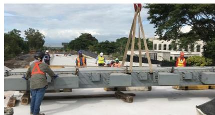
Nivelación y fijación del armado de refuerzo para TENSA®MODULAR antes de colar el concreto
