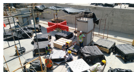
Aisladores en obra, listos para ser instalados
