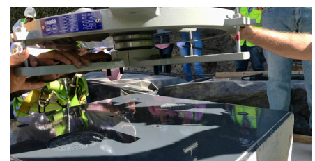
Instalación de un RESTON®SLIDER, que será conectado con tornillos y rondanas a la placa de anclaje
