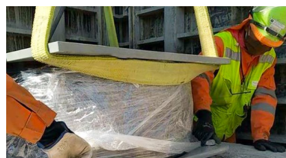
Instalación del aislador LASTO®LRB
