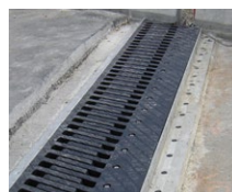
Juntas dentadas deslizantes
