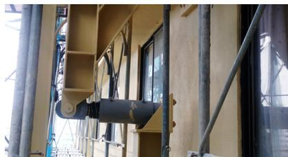
Todos los 296 amortiguadores RESTON®SA se ensayaron con éxito antes de la instalación
