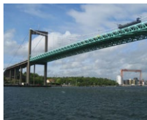
Ponte Alvsborg (SE)
