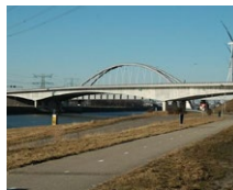
Ponte Dintelhaven (NL)
