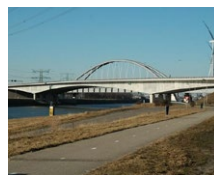
Ponte Dintelhaven (NL)
