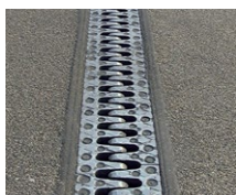
Juntas tipo pente metálico
