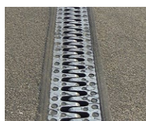
Juntas tipo pente metálico
