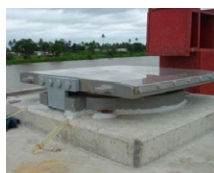
Apoios para Tabuleiros de lançamento Incremental
