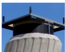
Apoios de deformação
