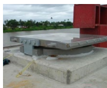
Apoios para tabuleiros de lançamento incremental
