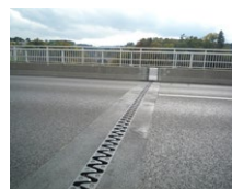
Viaduto Fürstenland (CH)
