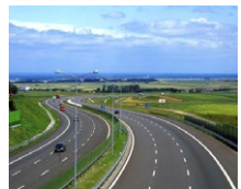
Autostrada Transilvania (RO)
