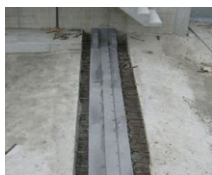
Шов перед бетонированием
