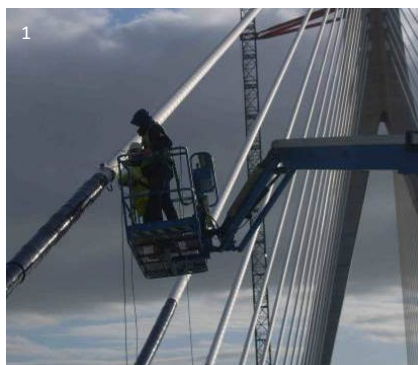
1 Установка сенсоров на вантовом мосту 2 Солнечная панель (опция)
