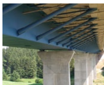
Мост «Штайнбахтал» (DE)
