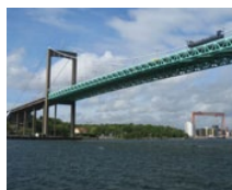
Мост «Альвсборг» (SE)
