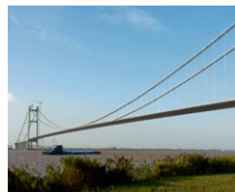
Run Yang Bridge (CN)
