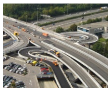
Bridge Glattzentrum (CH)
