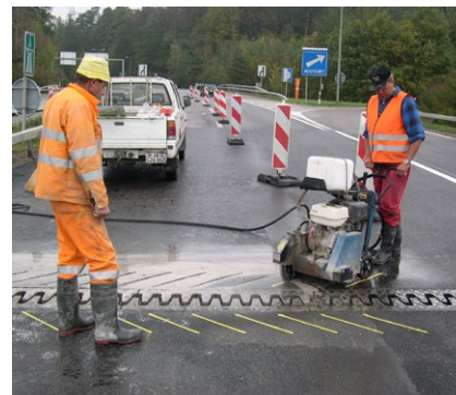
Нарезка штроб под углом 45° к оси проезда
