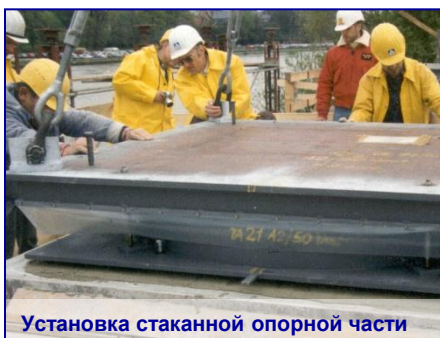
Сборка верхнего балансира и стакана
