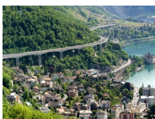
виадук de Chillon, Швейцария
