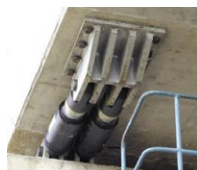
Резиновые ОЧ со свинцовым сердечником
