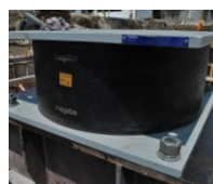
Резиновые ОЧ со свинцовым сердечником
