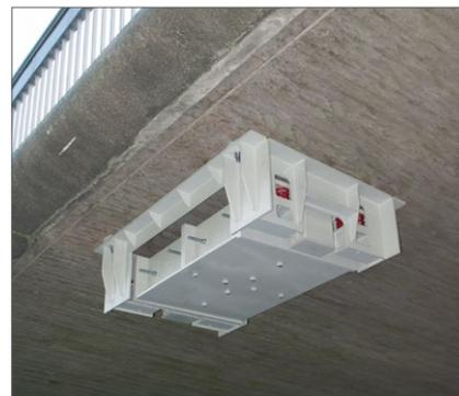
Динамический гаситель колебаний с собственной частотой 4,3 Гц и массой 3,5 т, установленный на мосту в Киле, Германия
