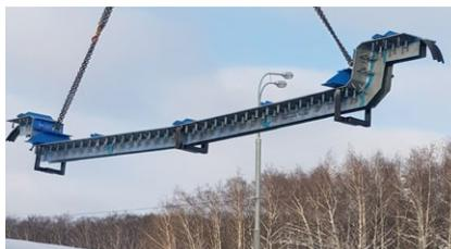
Омоноличенный шов TENSA®RAIL RSU
