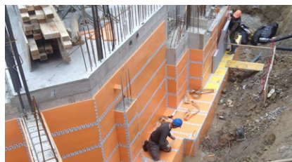
Установка боковых матов для виброизоляции
