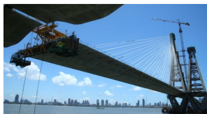
Bau eines Brückenfeldes mit Schrägseilen als Teil des Bandra Worli Sea Link
