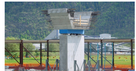
Brückenpfeiler mit mageba RESTON®POT Topflager
