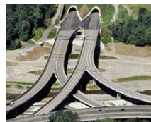
Westumfahrung ZH (CH)
