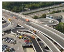
Brücke Glattzentrum (CH)
