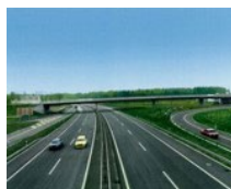
Autobahnüberführung Moosgasse, (CH)
