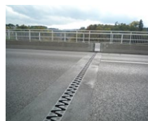
Fürstenland Viadukt (CH)
