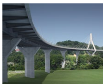
Pont de la Poya (CH)
