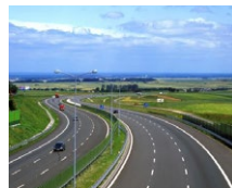
Autostrada Transilvania (RO)
