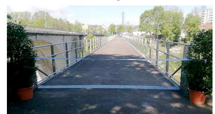
Ansicht nach Einbau der Fuge
