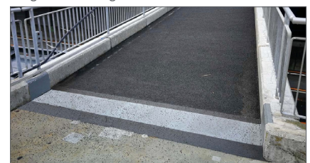
Eingebaute neue Belagsdehnfuge an der Überführung Schützenweg
