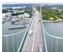
Älsborgbron Brücke (SE)
