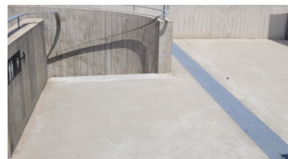
Frisch eingebaute POLYFLEX®SLIM PU Belagsdehnfuge
