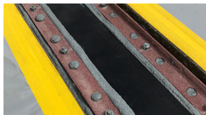
Einbau der Fuge mit Montageeinlagen
