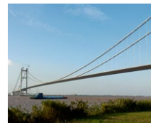
Run Yang Bridge (CN)
