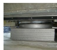
Kalotové ložisko
