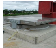
Výsuvné ložisko
