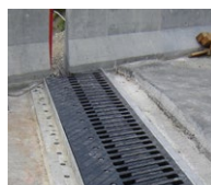
Klzný hrebeňový mostný záver
