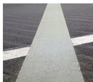
Elastický zálievkový mostný záver
