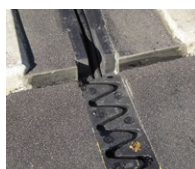
Jednoprofilový mostný záver
