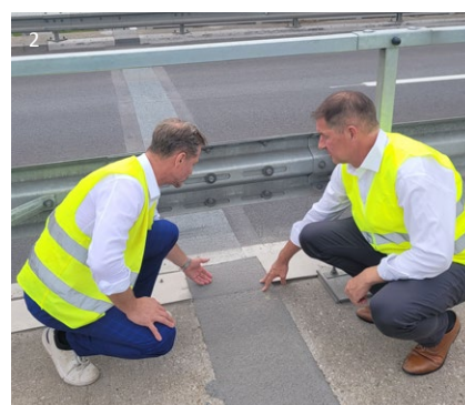
Elastický zálievkový mostný záver
