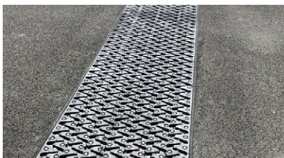
Osadený mostný záver typu: TENSA®MODULAR LR7-LS
