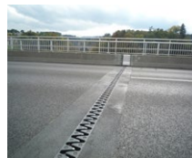
Fürstenland Viadukt (CH)
