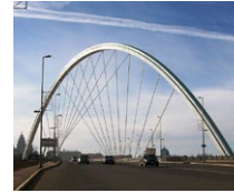
Ramstore Köprüsü (KZ)
