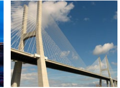
Vasco da Gama Köprüsü (PT)
