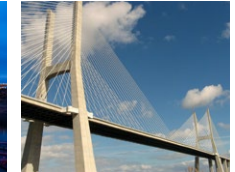
Vasco da Gama Köprüsü (PT)
