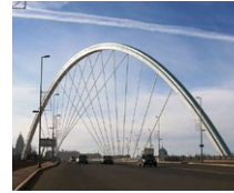
Ramstore Bridge (KZ)
