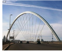
Ramstore Bridge (KZ)
