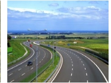
Autostrada Transilvania (RO)
