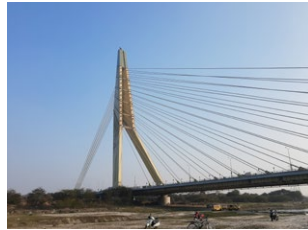
Wazirabad Köprüsü, Hindistan
