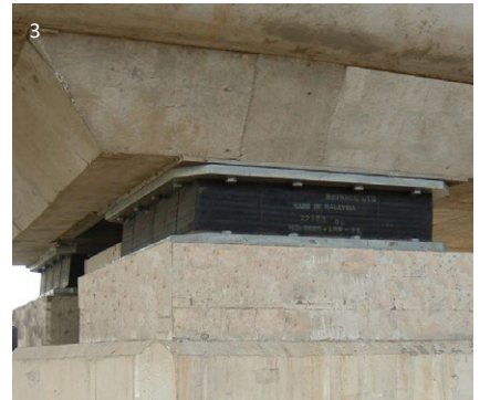
Yukarı kaldıracı yüklerle karşı dizaynı mesnet
